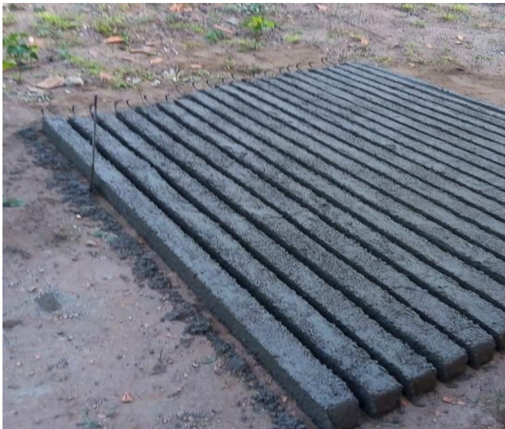
Figura 06 – Caibros para cobertura
