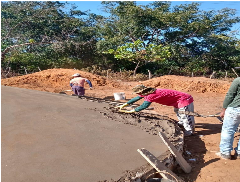
Figura 10 – Reboco da cobertura
