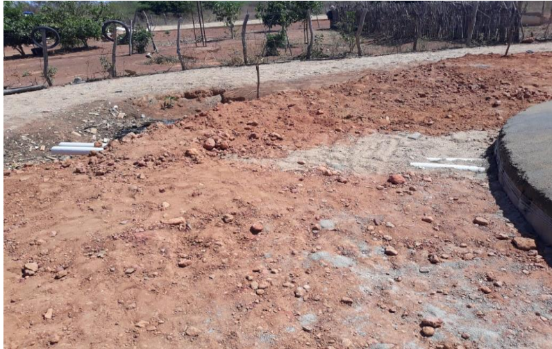
Figura 11 – preparo da área do calçamento
