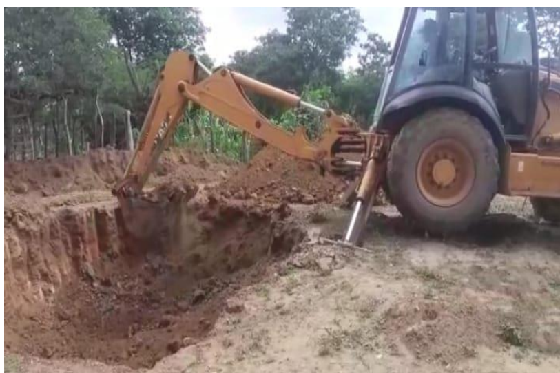
Figura 03 – Escavação do buraco
