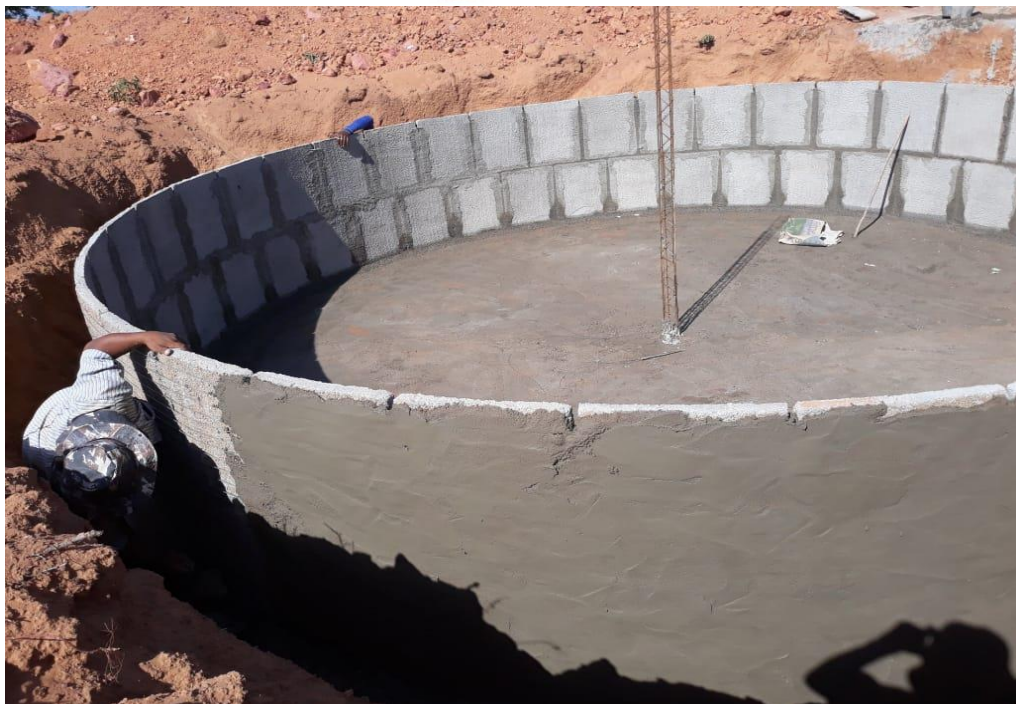
Figura 09 – acabamento das paredes
