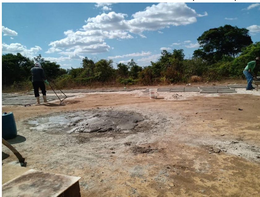
Figura 04 – Confeção de placas da cisterna
