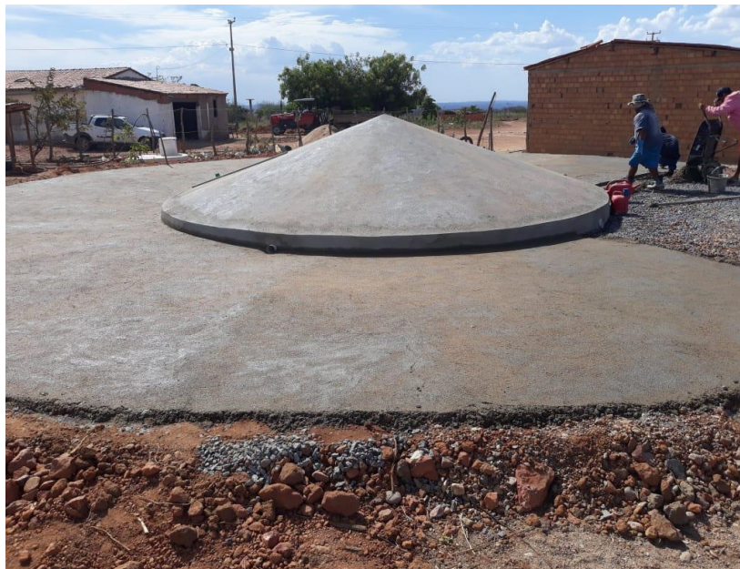
Figura 12 – Construção do calçamento
