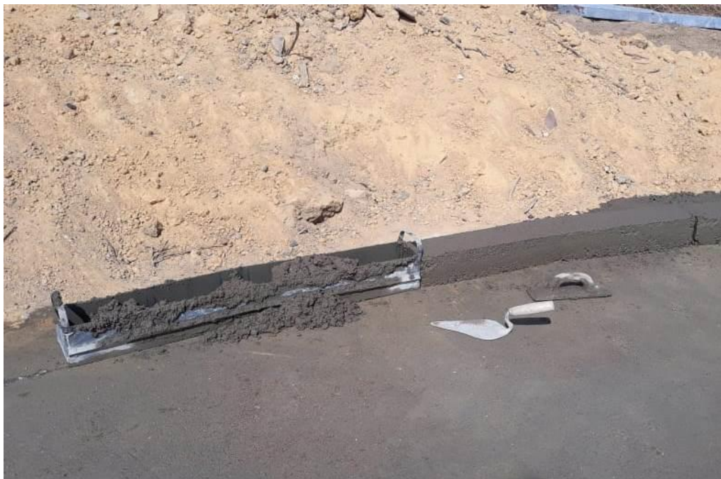
Figura 13 - construção do meio fio
