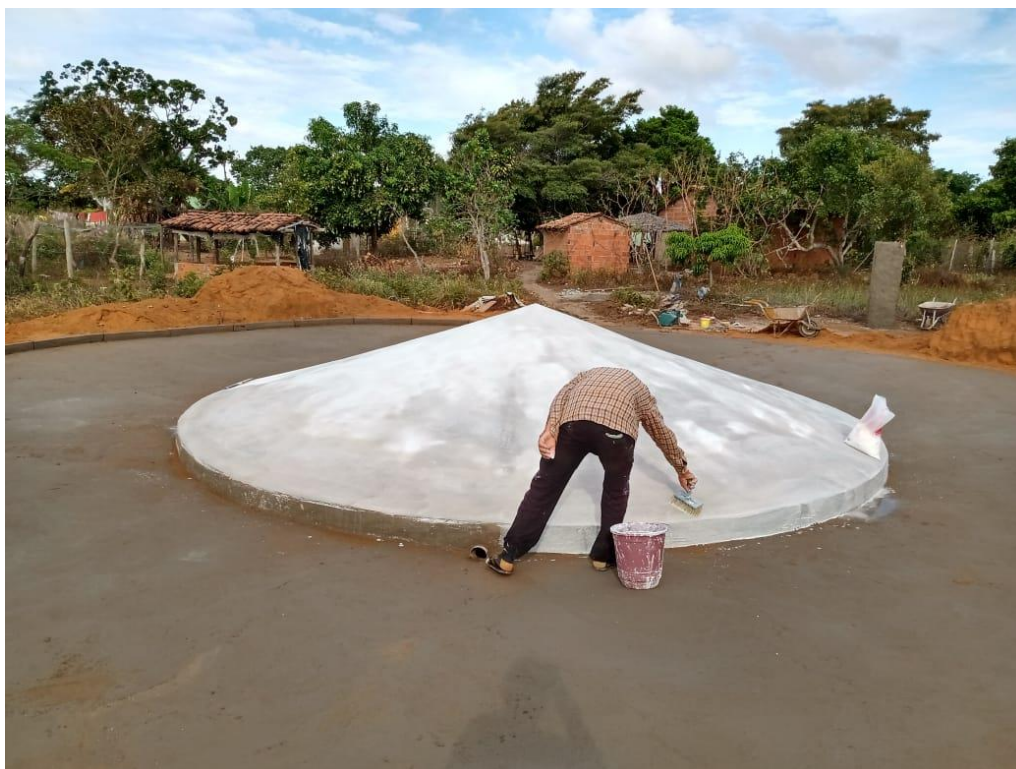
Figura 14 - Pintura da cisterna
