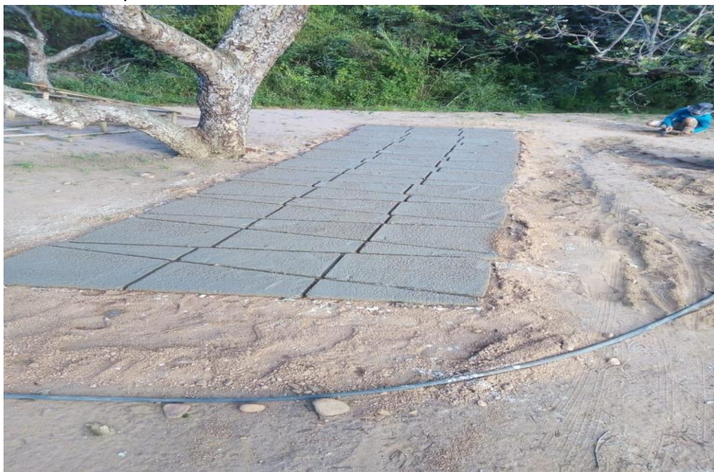
Figura 05 placas da cobertura
