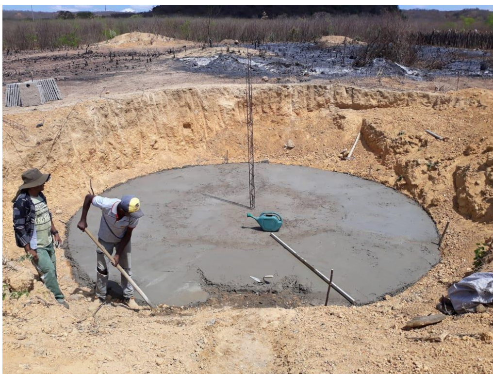
Figura 08 – Construção do Piso
