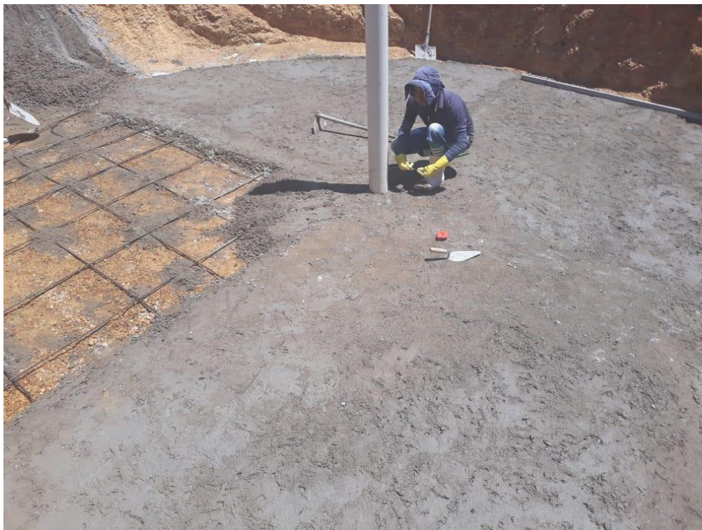
Figura 07 – Armadura de ferro do piso
